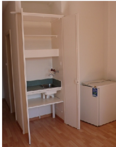
Lavabo in Schrank. Plattenstr. 46, 8032 Zürich
